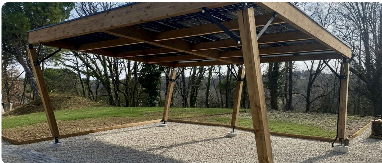
La charpente en Douglas d'un Volto, fabriquée dans notre atelier de Servian.
